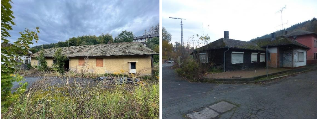
Abbildung 6, 7 Baufällige Gebäude, leerstehend unbewohnt. (S. Krebs, 26.09.23)
