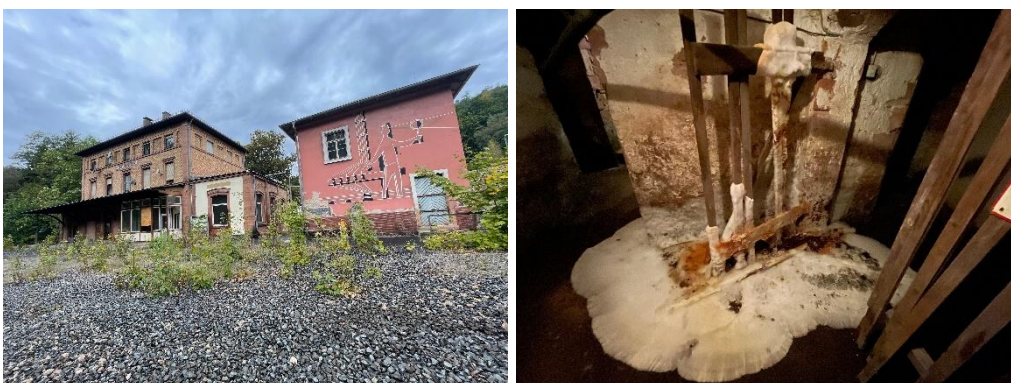
Abbildung 4, 5 Bahnhofsgebäude: links Sandsteingebäude zur Zeit der Untersuchung auf Fledermausvorkommen bewohnt; rotes Gebäude rechts baufällig und unbewohnt; Abb. 5 Schimmelpilz im Keller des bewohnten Sandsteingebäudes (S. Krebs, 26.09.23)
