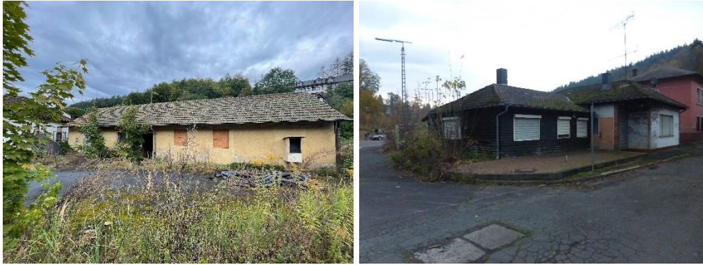
Abbildung 6, 7 Baufällige Gebäude, leerstehend unbewohnt. (S. Krebs, 26.09.23)
